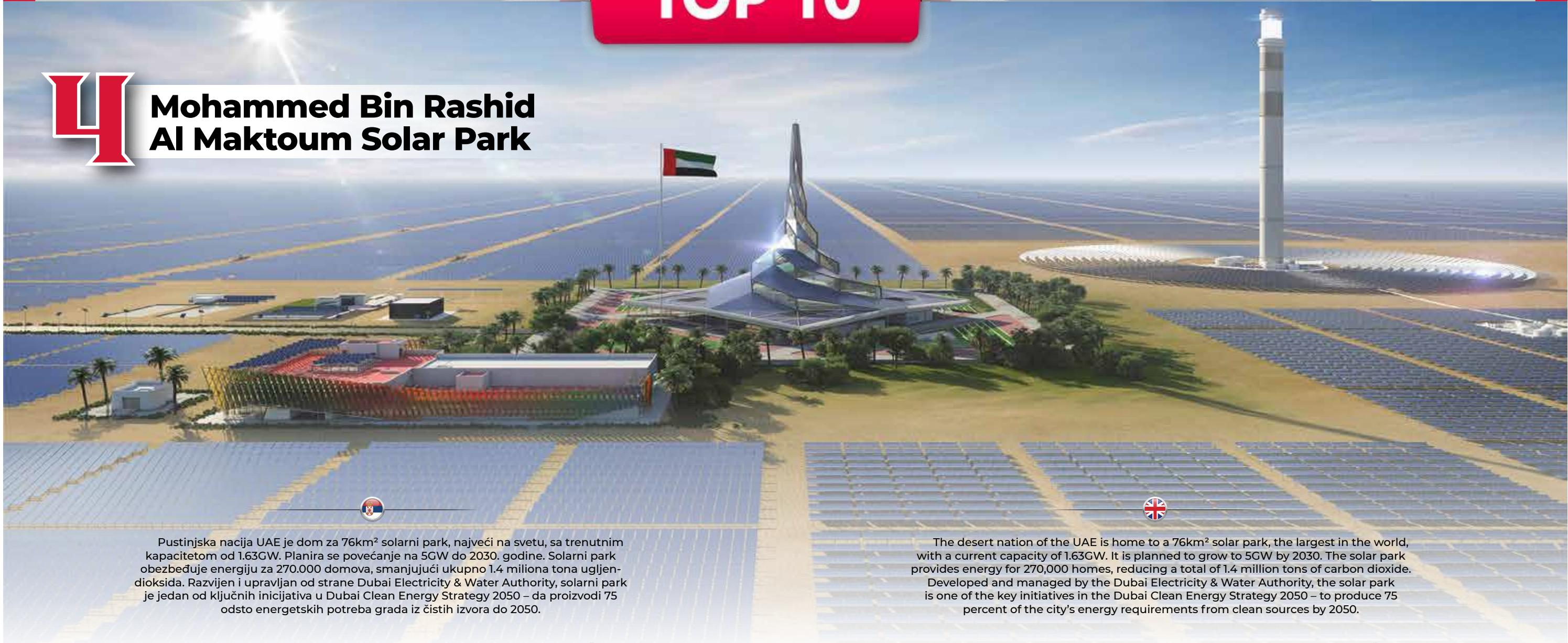
Pustinjska nacija UAE je dom za 76km<sup>2</sup> solarni park, najveći na svetu, sa trenutnim kapacitetom od 1.63GW. Planira se povećanje na 5GW do 2030. godine. Solarni park obezbeđuje energiju za 270.000 domova, smanjujući ukupno 1.4 miliona tona ugljen-dioksida. Razvijen i upravljan od strane Dubai Electricity & Water Authority, solarni park je jedan od ključnih inicijativa u Dubai Clean Energy Strategy 2050 – da proizvodi 75 odsto energetskih potreba grada iz čistih izvora do 2050.
